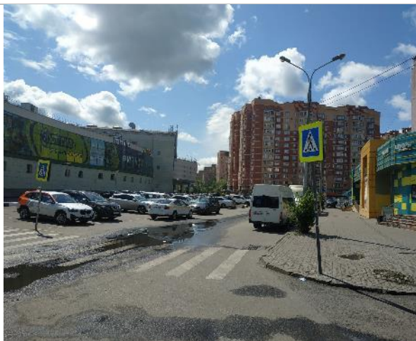
Фотография 88. Фасад здания, прилегающая территория и подъездные пути.
