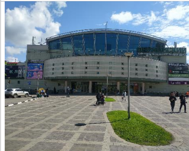
Фотография 93. Фасад здания, прилегающая территория и подъездные пути.
