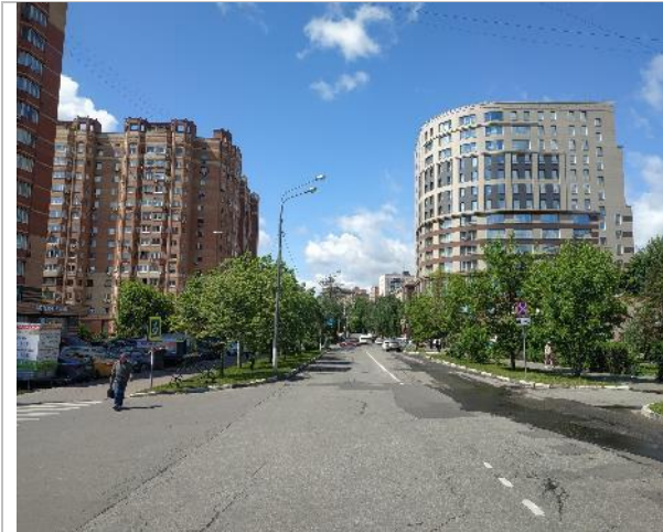
Фотография 91. Фасад здания, прилегающая территория и подъездные пути.
