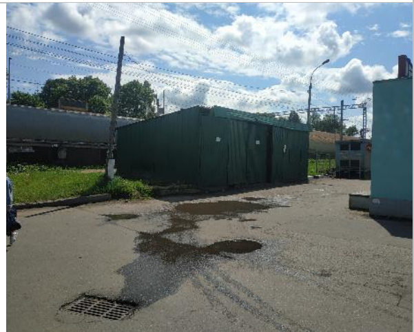
Фотография 82. Прилегающая территория
