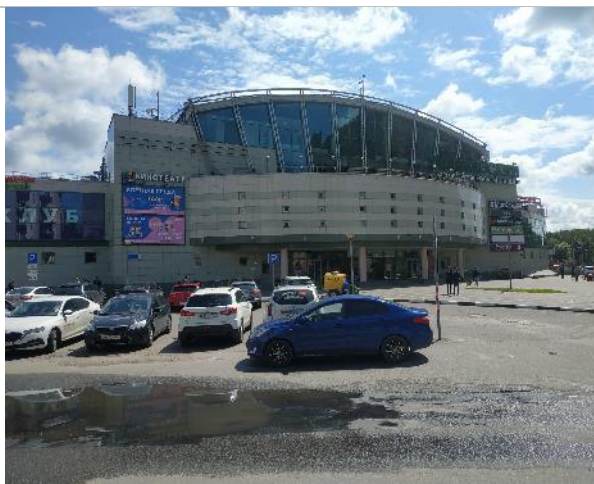
Фотография 89. Фасад здания, прилегающая территория и подъездные пути.
