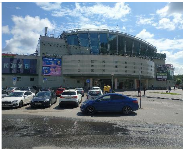
Фотография 90. Фасад здания, прилегающая территория и подъездные пути.
