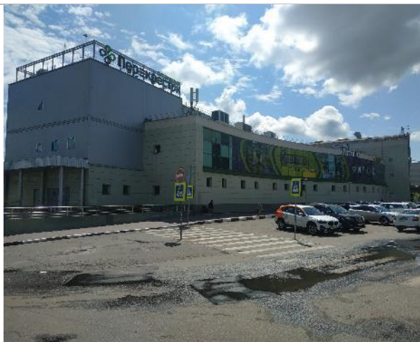
Фотография 87. Фасад здания, прилегающая территория и подъездные пути.
