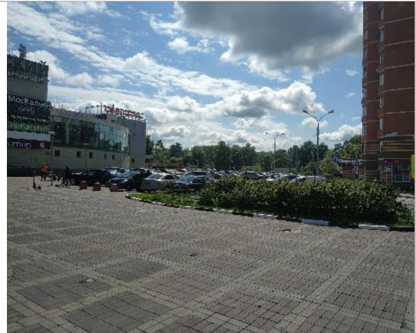
Фотография 92. Фасад здания, прилегающая территория и подъездные пути.
